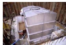
雨水貯留施設
