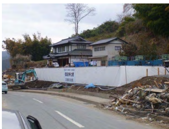
写真 I-1-47 仮設処理場設置現場
