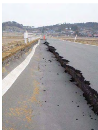
標準施工（未対策） 写真 I-1-22
