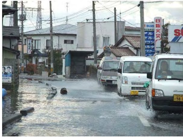
地盤沈下による道路冠水状況（１）
