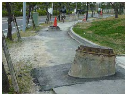
写真 I-1-27 浦安市の人孔突出
