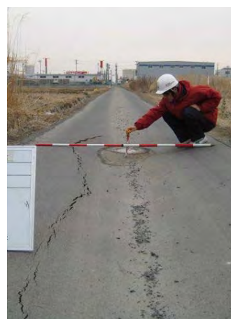
液状化対策施工（被害有り） 写真 I-1-24
