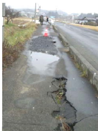
写真 I-1-25 標準施工（未対策）
