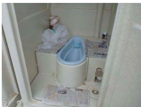
（詰り防止のため紙は分別回収） 写真 I-1-35 災害用仮設トイレ内（気仙沼小学校）
