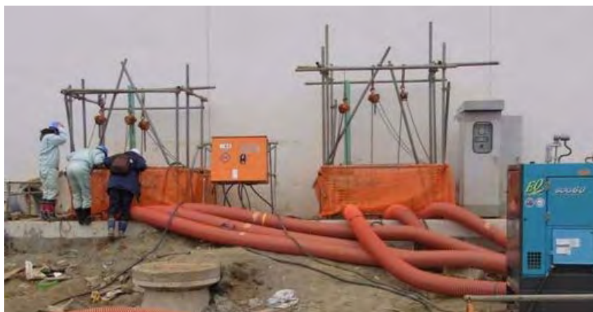
写真 I-1-32 流入きよからの仮設ポンプによる汚水くみ上げ （宮城県石巻東部浄化センター）
