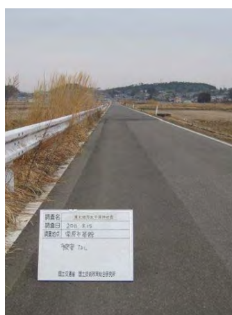
液状化対策施工（被害なし） 写真 I-1-23
