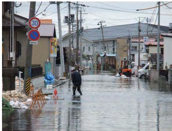
地盤沈下による道路冠水状況（２）
