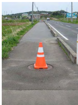
写真 I-1-26 液状化対策施工箇所（被災箇所）
