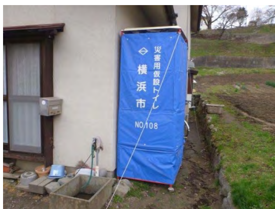
写真 I-1-45 一般家庭への仮設トイレ配備
