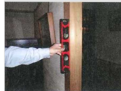
水平器による柱の傾きの計測
