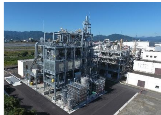
固形燃料化施設(静岡市中島浄化センター)
