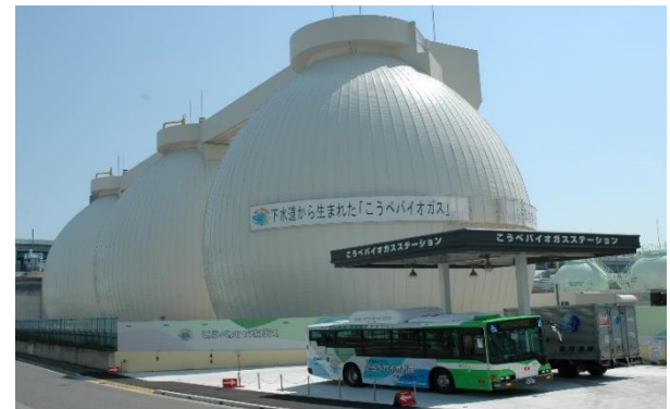
バイオガスを精製して自動車燃料として供給(神戸市)
