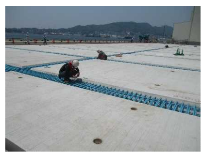
床版設置の様子
