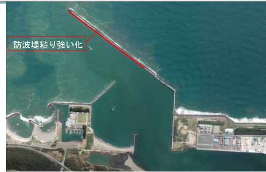
宮崎港防波堤
