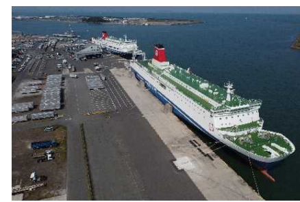
整備が完了した新門司地区
