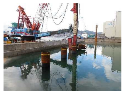
鋼管杭打設の様子
