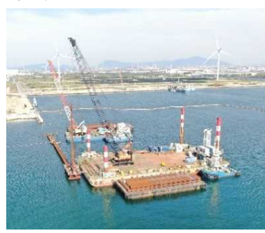
基地港湾整備の様子
