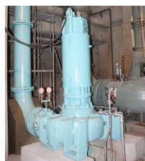
設備機器の防水化 (耐水型モーター)
