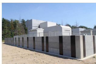
防水壁の設置
