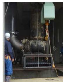
仮設ポンプの設置
