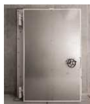
防水扉の設置
