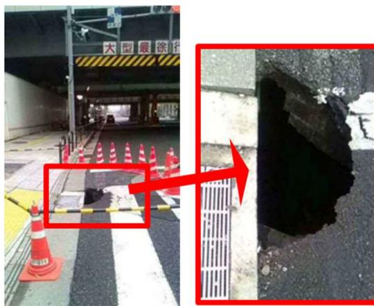
図 5.4 ビルピット排水由来の硫化水素による道路陥没事故（令和2年）
