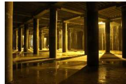
貯留施設の整備
