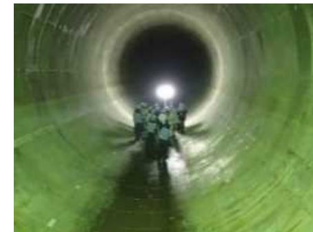
雨水貯留管の整備
