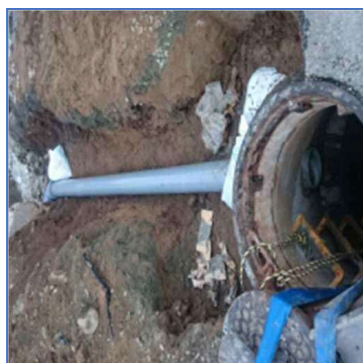
別幹線MHへ仮設管を布設
