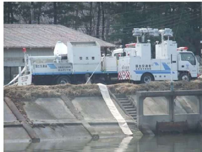
移動ポンプ車による排水
