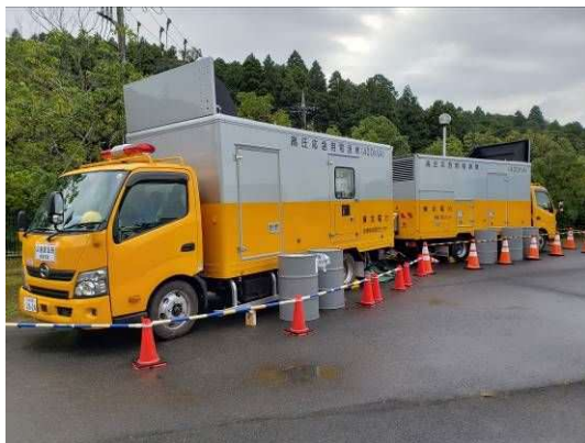
電源車設置状況（芝山CC）
