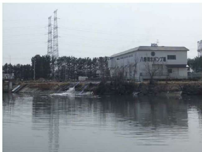
仮設ポンプによる排水
