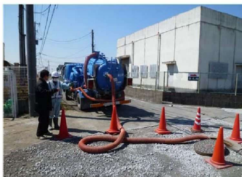
汚泥吸引車による吸引状況
