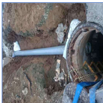
別幹線MHへ仮設管を布設
