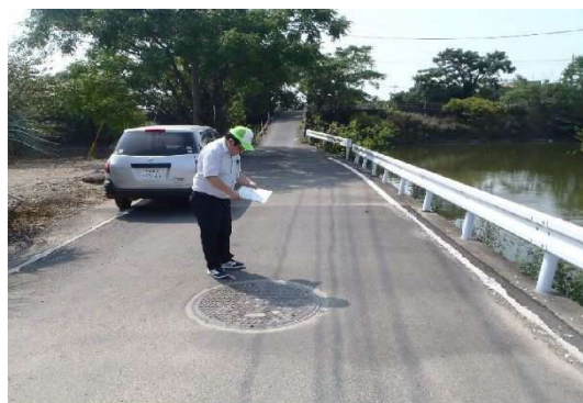
(13) 緊急点検状況(管渠・MH)
