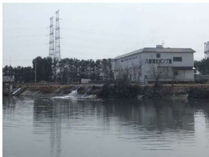
仮設ポンプによる排水
