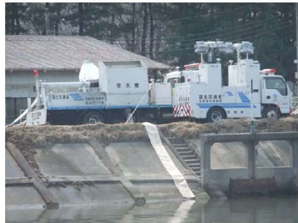
移動ポンプ車による排水
