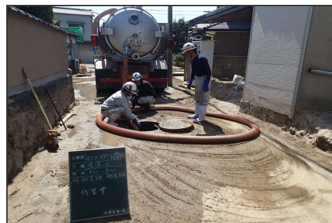
管路内土砂除去状況（広島市）
