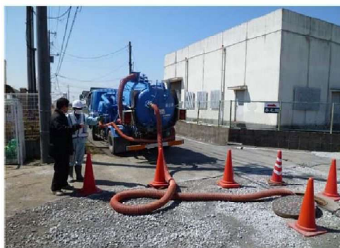
汚泥吸引車による吸引状況
