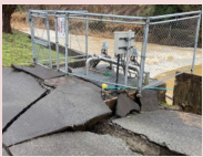
水道の復旧（被災した浄水場）
