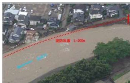
侵食により家屋が流失した状況
