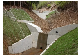
治山ダムの整備（愛知県）
