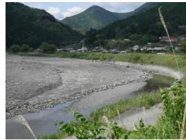
河道掘削（静岡県）
