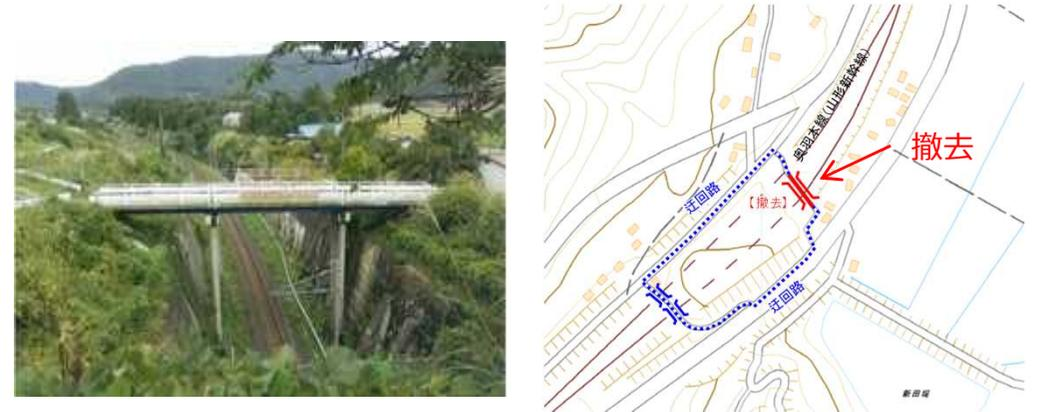
新幹線を跨ぎ、約60年経過し老朽化が進捗した跨線橋を、維持管理費の削減を図るとともに、橋下空間の安全を確保するため、撤去を実施。
